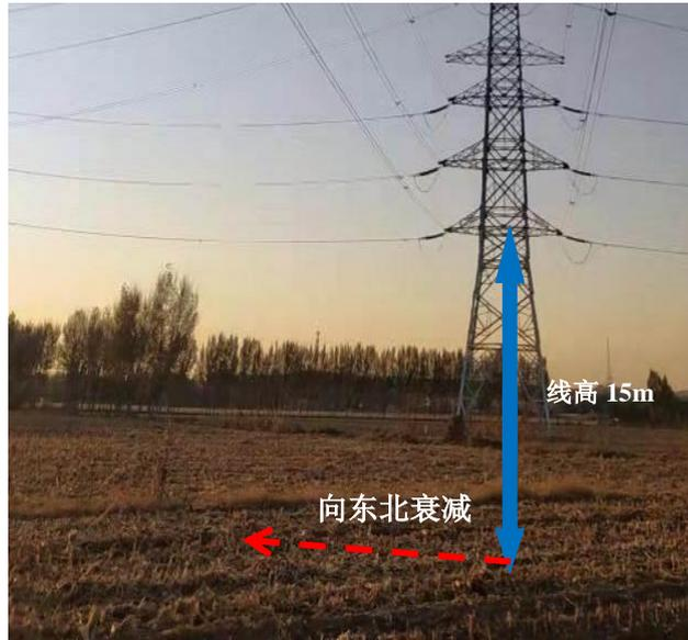
图 7-1 220kV 章宝线/220kV 王章线双回架空线路衰减断面
