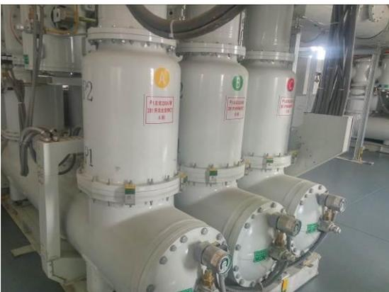
图 4-9 220kV 配电装置
