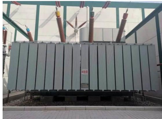
图 4-8 #2 主变压器
