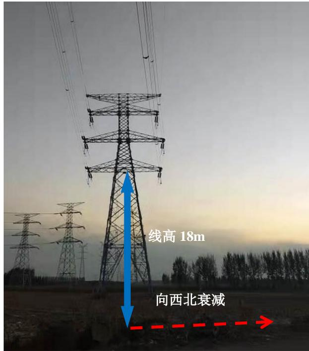
图 7-3 220kV 章宝线/220kV 王泉线双回架空线路衰减断面
